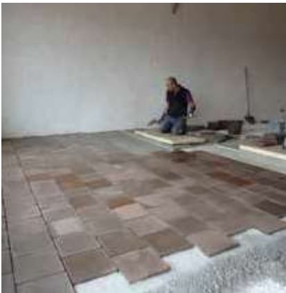
Pose de carreaux moulés main en terre cuite teintée dans la masse.
