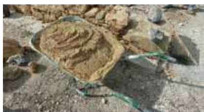
Montage du mur en pierres hourdées avec un mortier de chaux.
