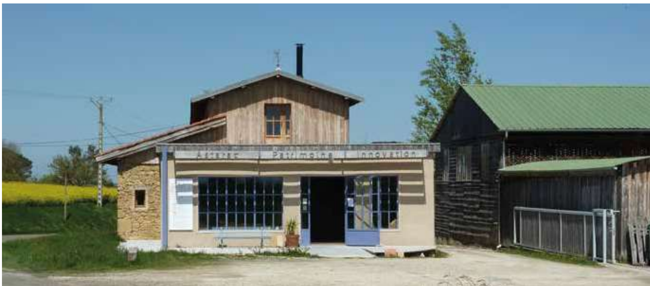
Le nouveau bâtiment de négoce de matériaux écologiques pour un habitat sain valorise une ancienne friche.
