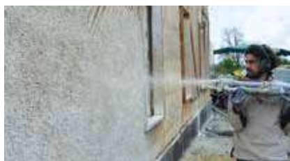
Projection du mortier de chaux et chanvre destiné à isoler les murs du rez-de-chaussée.
