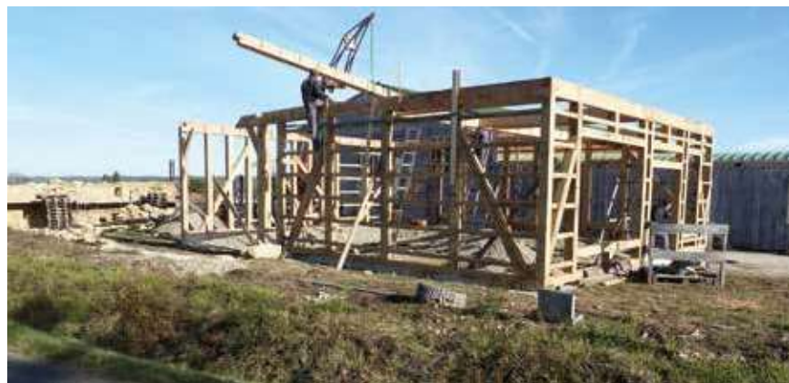
Montage de l'ossature en chêne du magasin.
