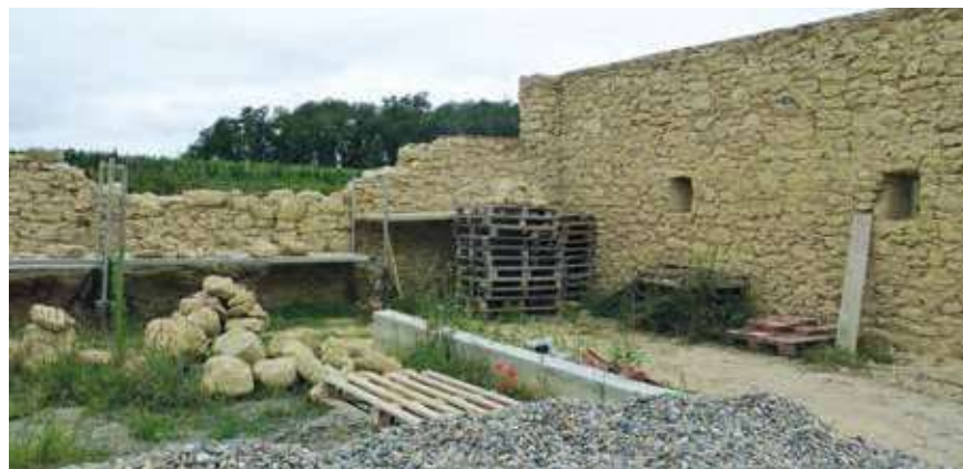
Les murs en pierres de récupération se dressent progressivement.
